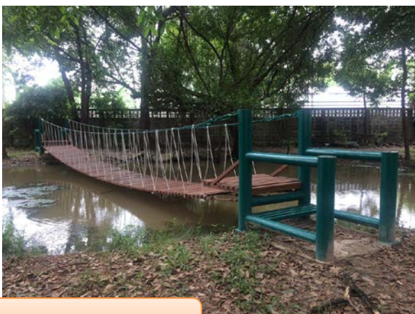
17. สะพานข้ามคลอง
